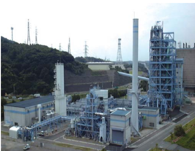
写真-1 パイロット試験設備外観
