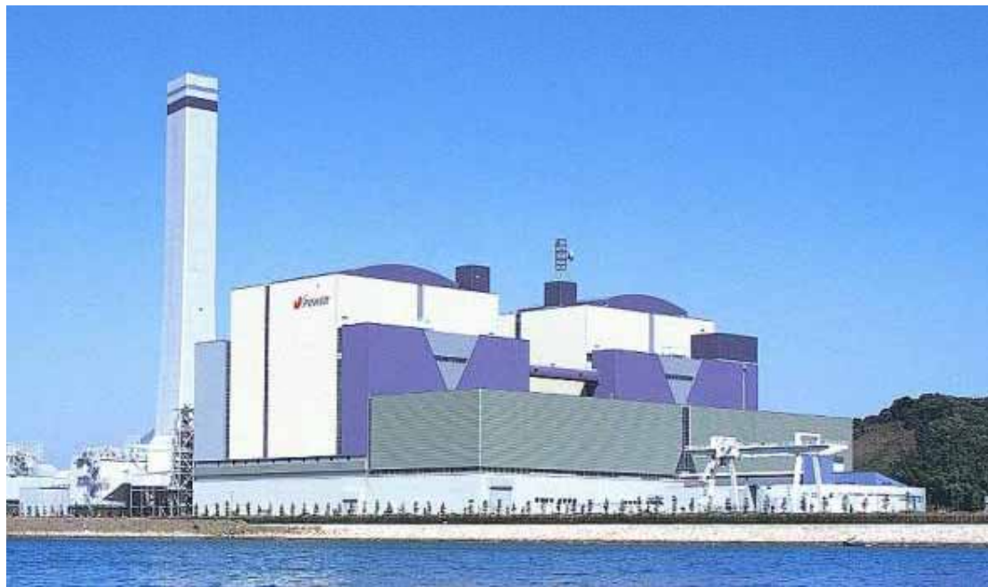
Jパワー橋湾火力発電所(徳島県)
