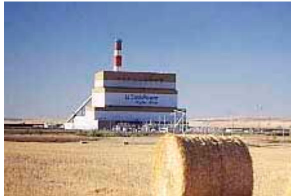
Poplar River発電所60万KW
