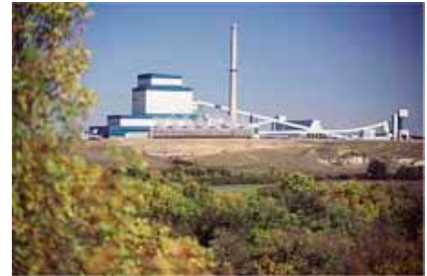
Shand発電所30万KW
