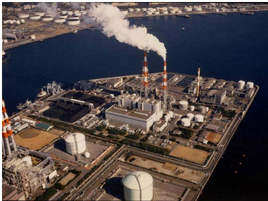
磯子火力発電所(横浜市) 1967年運転開始
