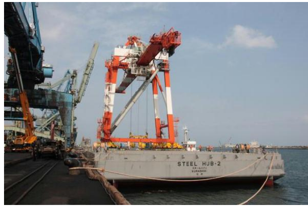
和歌山から到着した移設クレーン
