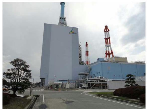
4月28日（排熱回収ボイラ付近）
