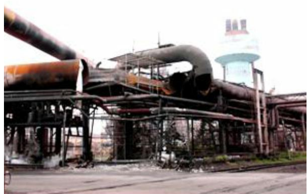
復旧工事の様子
